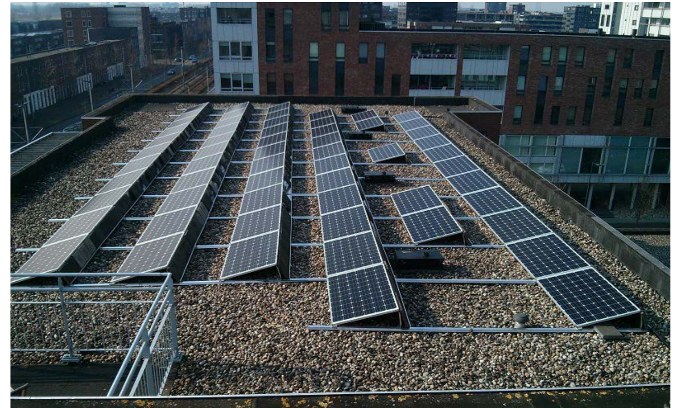
Zonnepanelen op lege dakoppervlakken van openbare gebouwen bijvoorbeeld via een 'postcoderoos'.
