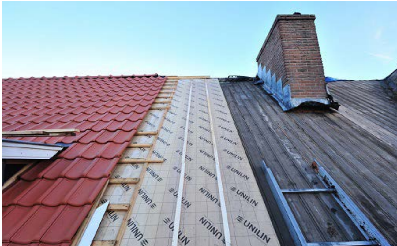
Particuliere woningverduurzaming door na-isolatie van daken.
