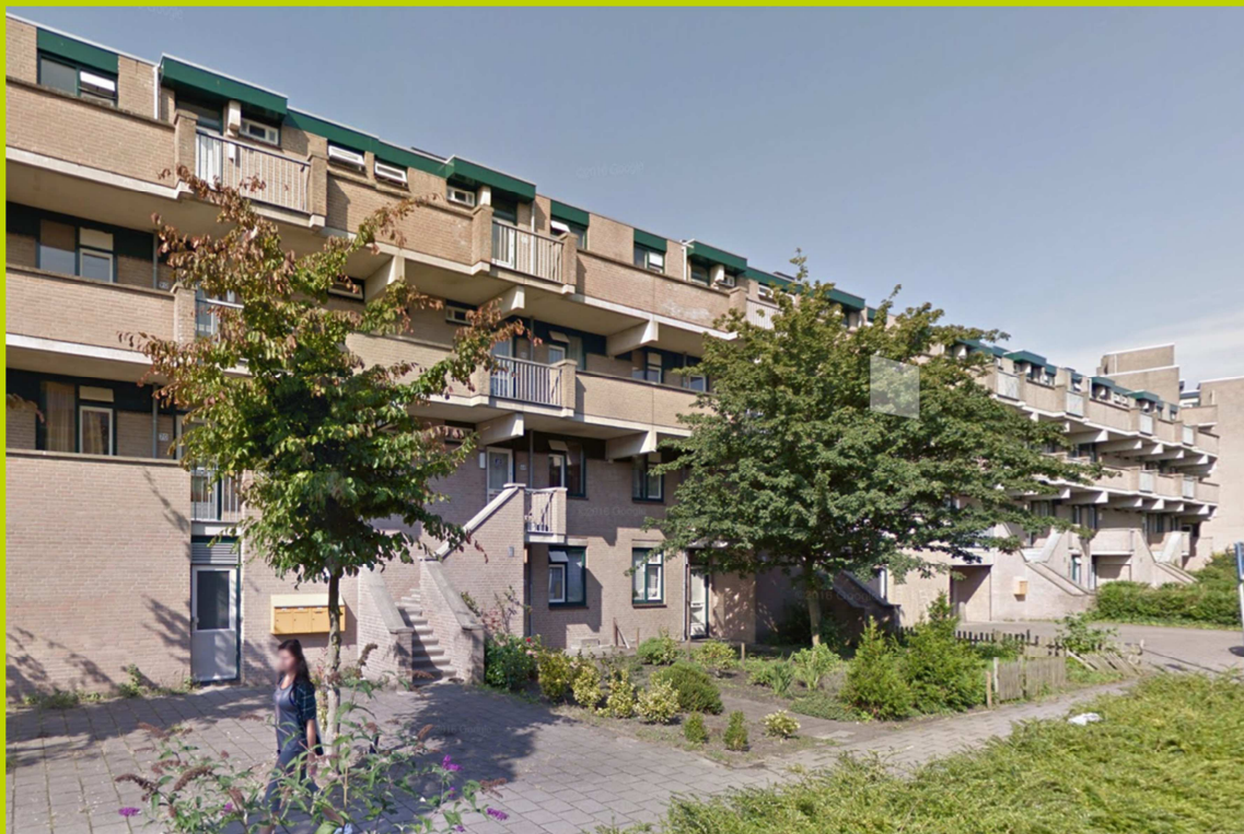
Hofbebouwing aan de straatzijde. Buitentrappen die leiden naar de woningen op de eerste verdieping; de woningen op de overige verdiepingen worden ontsloten via brede galerijen. De benedenwoningen zijn voorzien van voortuinen. Peursumstraat westzijde. (Google streetview, augustus 2015)
